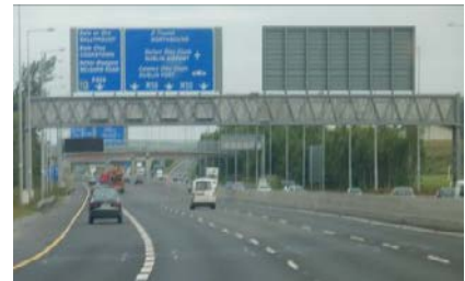
a) Portal Gantry
